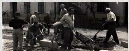
BUDOVÁNÍ SILNICE. Obyvatelé Bohutic pomáhali při budování silnice u domu Schovancových (dnes zde bydlí Bloudíčkovi) a Neherů (dnes Práškoví). Zleva je Karel Prášek, Karel Štefl, Rudolf Čunderlík. V pozadí je František Vespalec, napravo s lopatou pracuje Josef Kallna.
