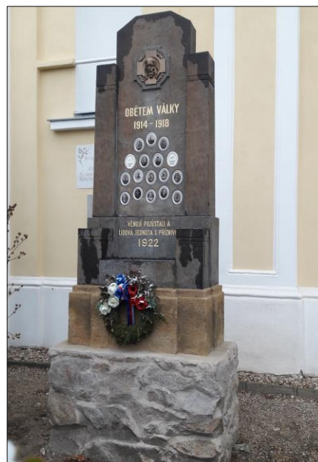
Foto po opravě
